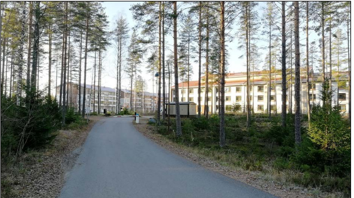
Kuva 5. Suunnittelualueella on olemassa olevaa tiestöä. Tasaaisella alueella Urheiluopistontien länsipuolella on useita kerrostalotyyppisiä lomahuoneistoista koostuvia rakennuksia (vasemmalla) ja hotelli (oikealla). Koillisessa on pientalotyyppisiä loma-asuntoja.
