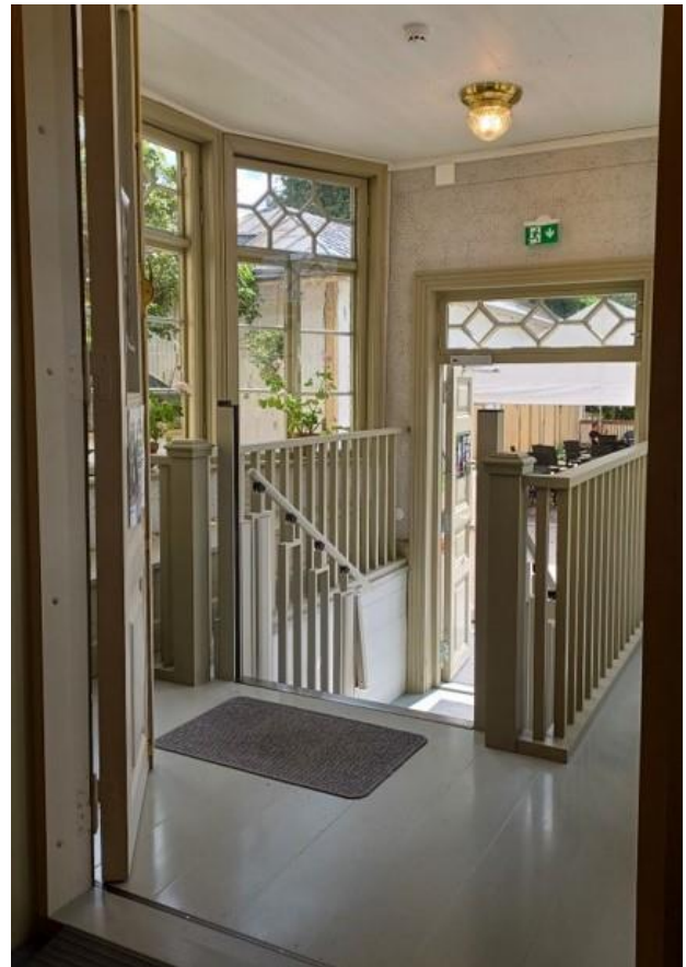
Restauroitu kuisti ja oven edusta. Oikealla kuvassa porrasnostin paikalleen asennettuna.
