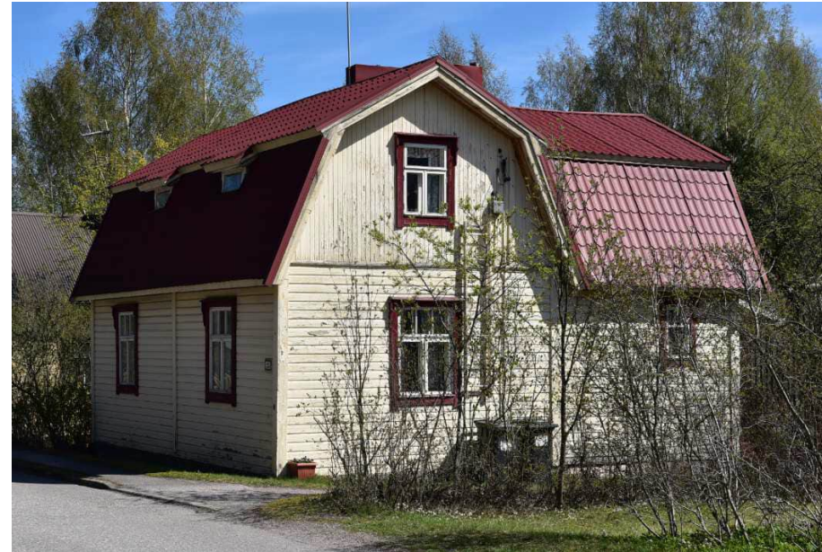
Kuva: Jyrängöncatu. Mansardi- eli taitekatto oli suosittu 1920-luvun alkuun saakka, koska katto mahdollisti pieneenkin taloon tilavien lisähuoneiden teon ullakkokerrokseen. Harjakatto vakiinnutti asemaansa 1920-luvulta lähtien. Se sopi perinteiseen, yksikertaiseen rakennustapaan ja omakotitalomalliin, johon pientalorakentamista ohjattiin valtion harjoittamalla tukipolitiikalla ja asuntonormien määrittelyllä sekä tyyppiirustusten kehittälyllä.
