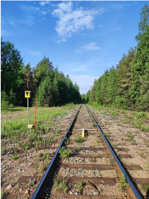
Kuva 9.1. Jyrängön pohjavesialueella kulkevaa rataosuutta.
