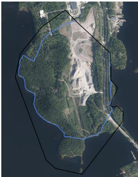
Kuva 8.1. Soranottoalue käsittää merkittävän osan Hevossaaren pohjavesialueen varsinaisesta muodostumisalueesta (Paikkatietoikkuna 2024).
