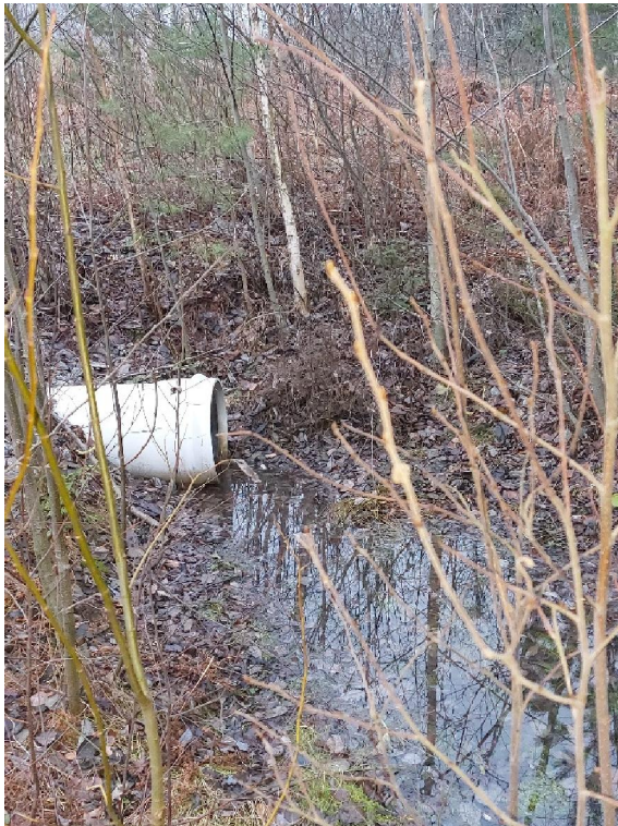
Kuva 3. Vääksyntien alittava rumpu Vääksyntien pohjoispuolella selvitysalueella (Ramboll 8.11.2024)
