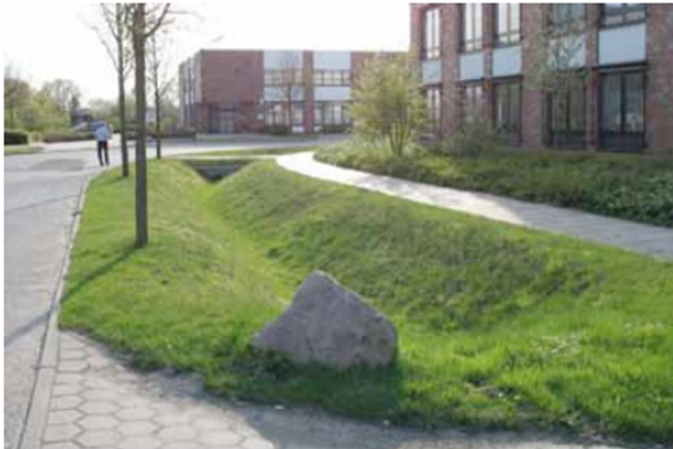
Kuva 16. Esimerkkikuva viherpeitteisestä ojasta (Hulevesiopas 2012)
