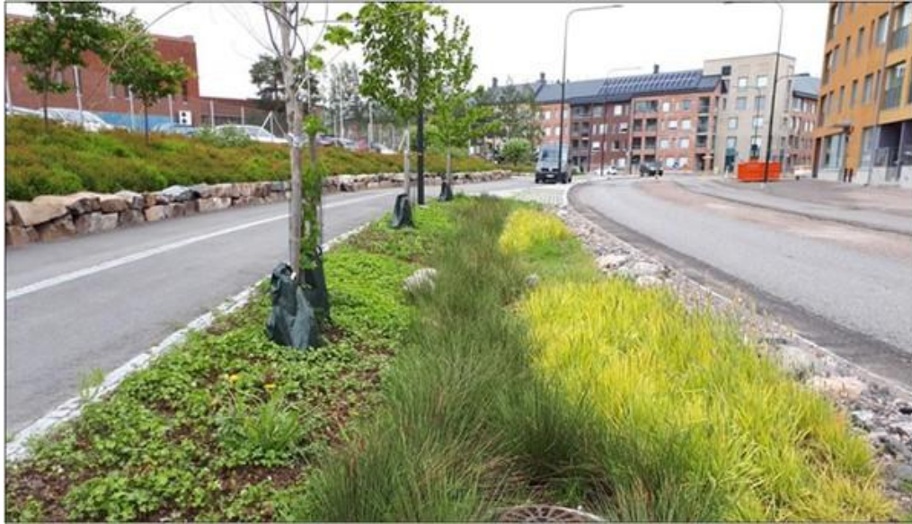
Kuva 14. Esimerkki biosuodatusrakenteesta (© Ramboll)
