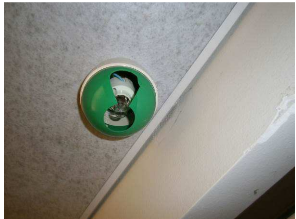
Poistumisvalosta puuttuu pala
