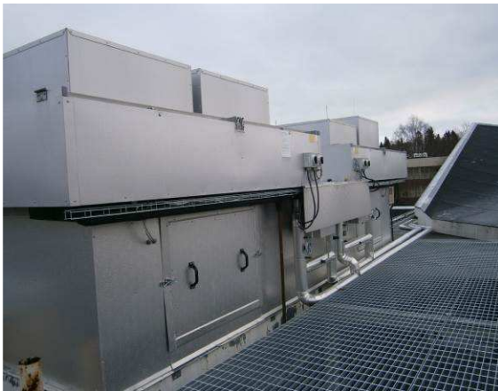
Poistoilmakoneissa on lämmöntalteenotto
