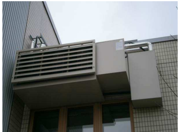
Tuloilman esilämmitys lämmöntalteenotolla
