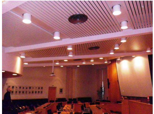
Valtuustotalo, jossa ei havaittu akuutteja kunnostustarpeita. Lattiat ovat lautaparkettia.
