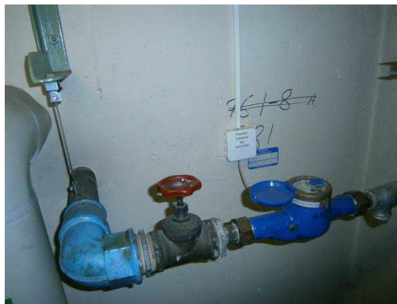
Päävesimittari
