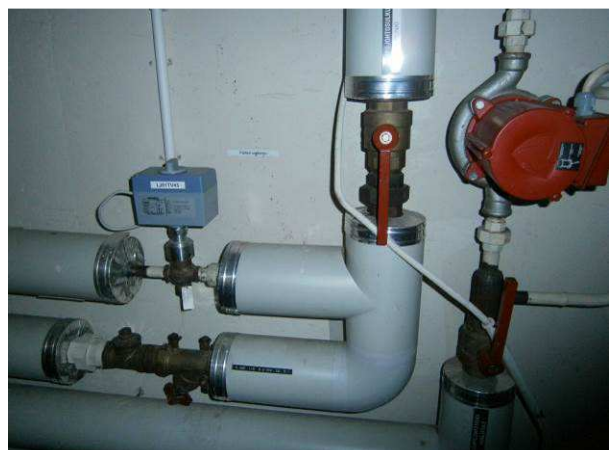
Valtuustotalon säätö- ja pumppuryhmä
