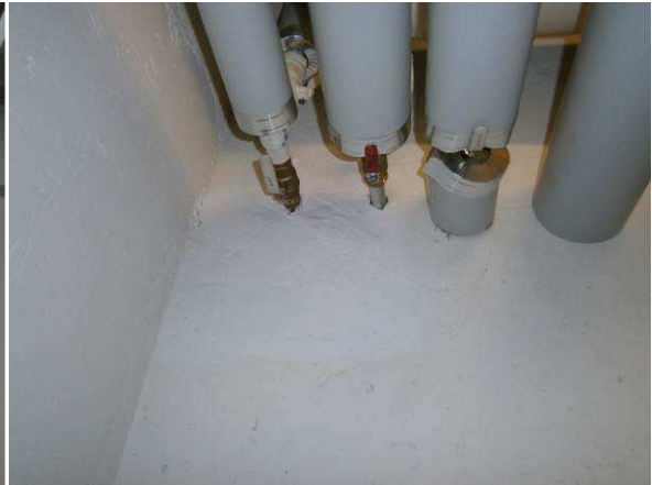
Yhdessä kohtaa linjaventtiilit ovat uusittu
