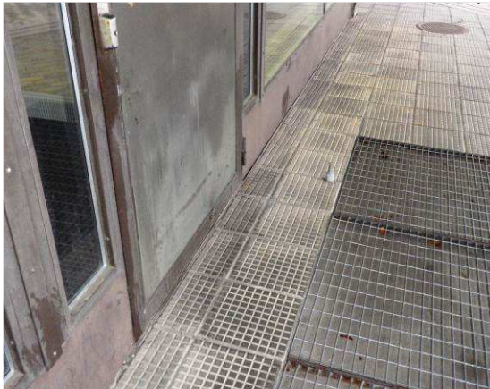
Pääovet ovat teräsumpiovia, joiden pielissä on 2k-eristyslasit.
