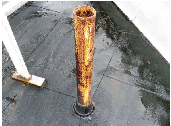
Suositellaan, että viemärin tuuletusputki huolto-maalataan.
