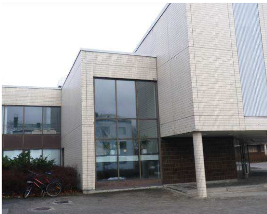
Osa ikkunoista on kiinteistä 3-k eristyslaselementeillä varustettuja ulkopuolelta teräslistoilla rhs-putkirunkoon kiinnitetyjä ikkunoita.
