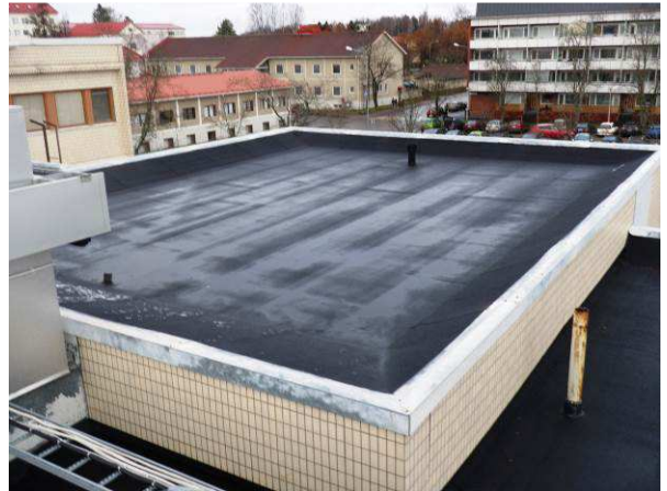
Alimman vesikatteen yleisnäkymää.
