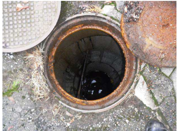
Tarkastuskaivon kansi avattuna. Kaivo on toimiva.
