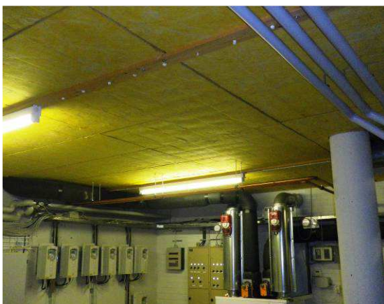
Iv-huoneen akustolevykatot suositellaan kapselointimaalattavan.
