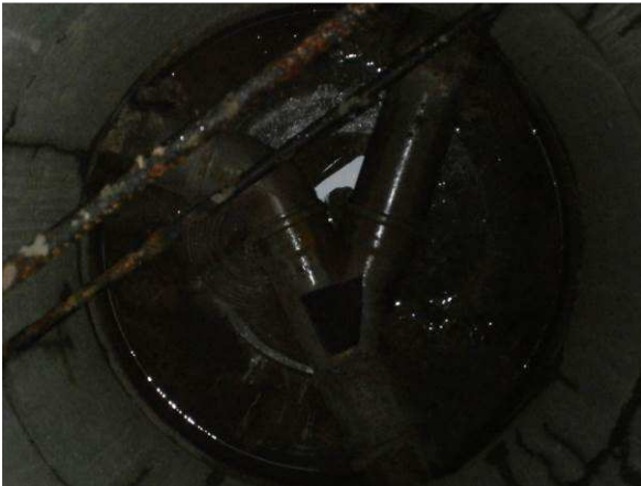
Pihan tarkastuskaivo on kunnossa
