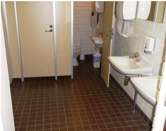
Wc-tilat ovat pääosin tyydyttävässä kunnossa.
