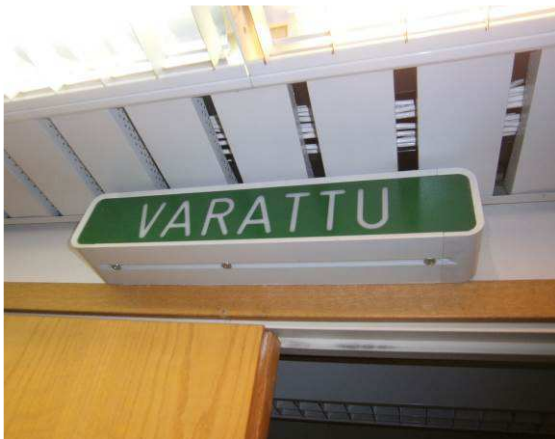
Varattu-valojärjestelmä
