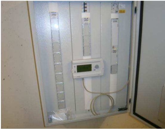
IV-koneiden säätölaitteet ovat uusia ja niitä ohjataan VAK-tyyppisellä automaatiolla.
