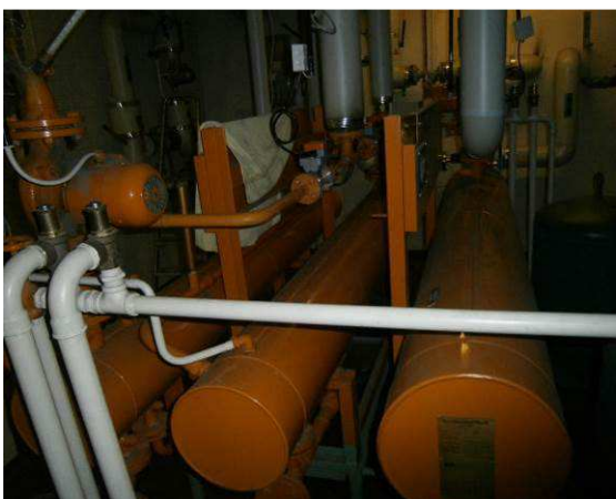
Lämmönsiirrinpaketti
