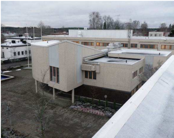
Vesikatteiden yleisnäkymää kuvattuna kaupungintalon vesikatolta.
