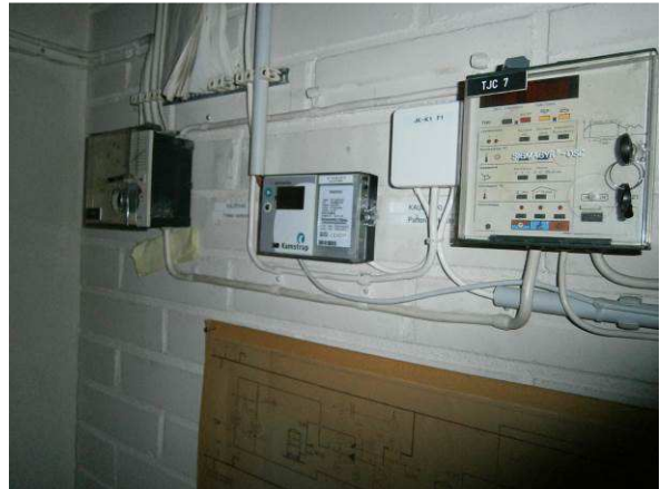
Valtuustotalon lämmityksen säätö tapahtuu yksikkösäätimillä
