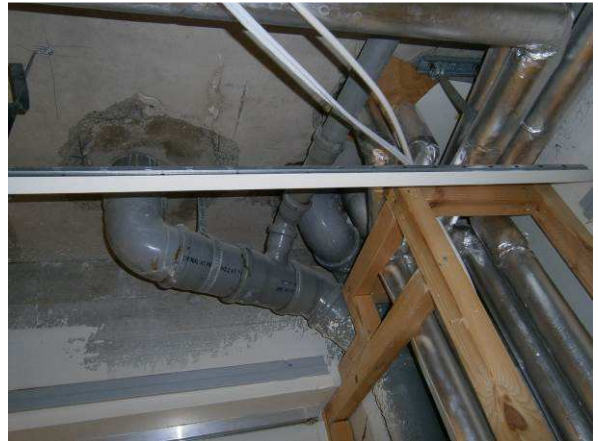
Viemärit ovat pääosin muovia
