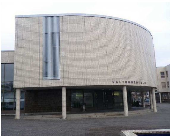
Kuvassa näkyy julkisivujen eri pintoja.
