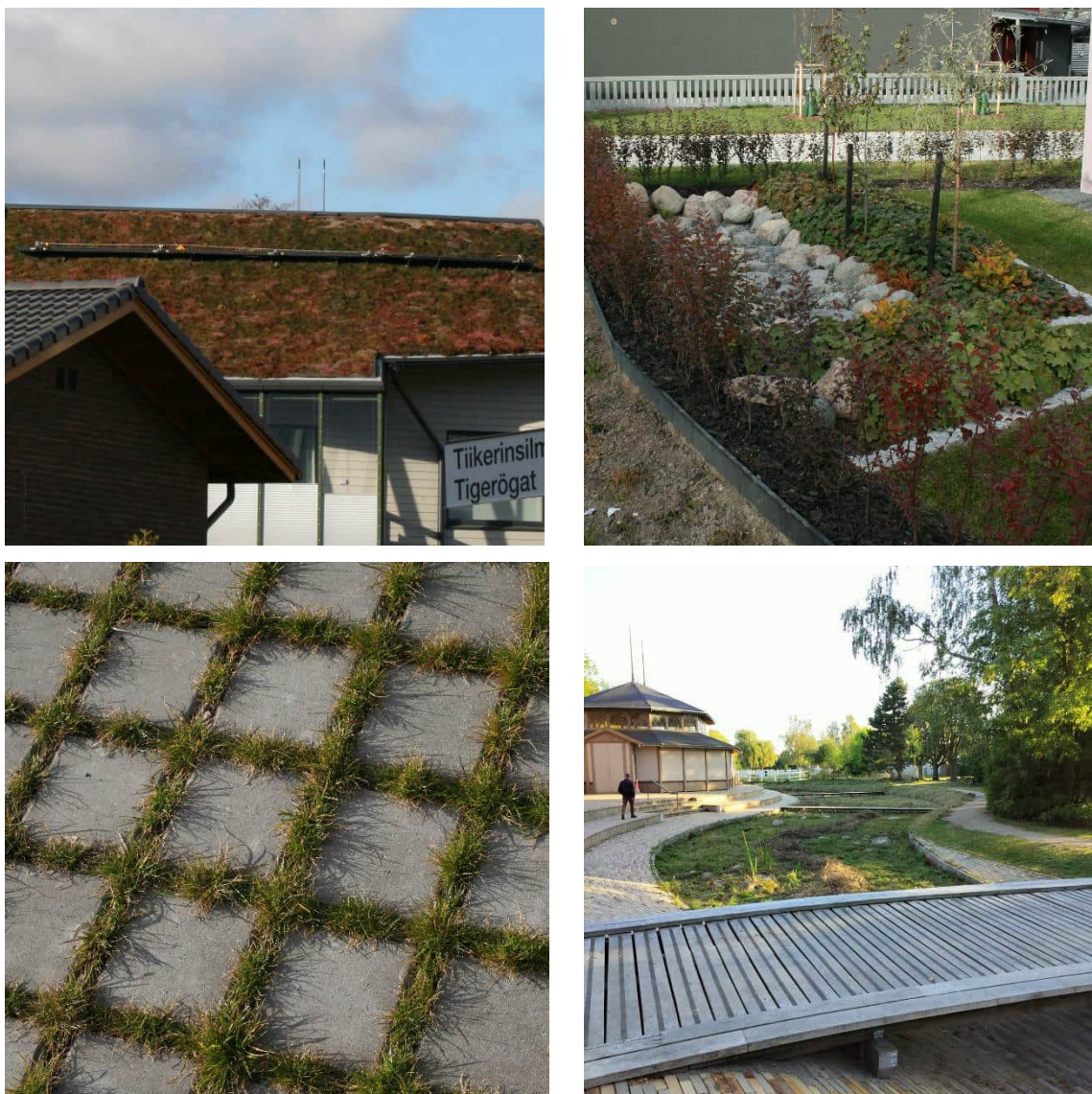
Kuva 13. Esimerkkejä hulevesien hallinnasta: a) maksaruohokatto, b) sadepuutarha, c) vettä läpäisevä kiveys, d) yleisen alueen hule- ja tulvavesien käsittely- ja johtamisratkaisu. (Kuvat: Terhi Renko)
