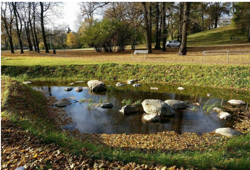
Kuva 1. Esimerkki sinivihreästä infrastruktuurista Helsingissä Töölönlahdella: puistoalueelle toteutettu hulevesien käsittelyrakenne (kuva: AFRY Finland Oy)
