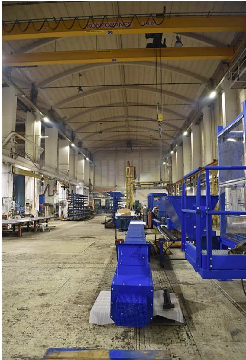
Kuva: Tehdashalli (korkeus n. 15 m) on kaksilaivainen, sivuilla ja keskellä on jyrkät pilarit, vetotangot kiinnittyvät holvikaton kaariin ja ylinnä näkyvät raudoitettut Siporex-kattolaatat.
