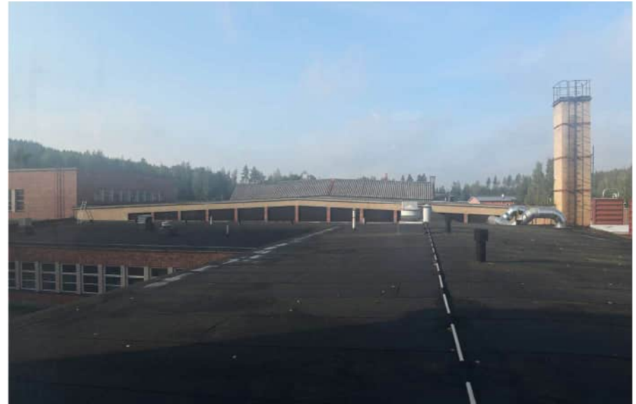
Kuva: Tehtaan matalan konttorisiiven ja vanhimman tehdashallin katot ja savupiippu. Päädyn ikkuna-aukkoihin on äskettäin asennettu levyt.
