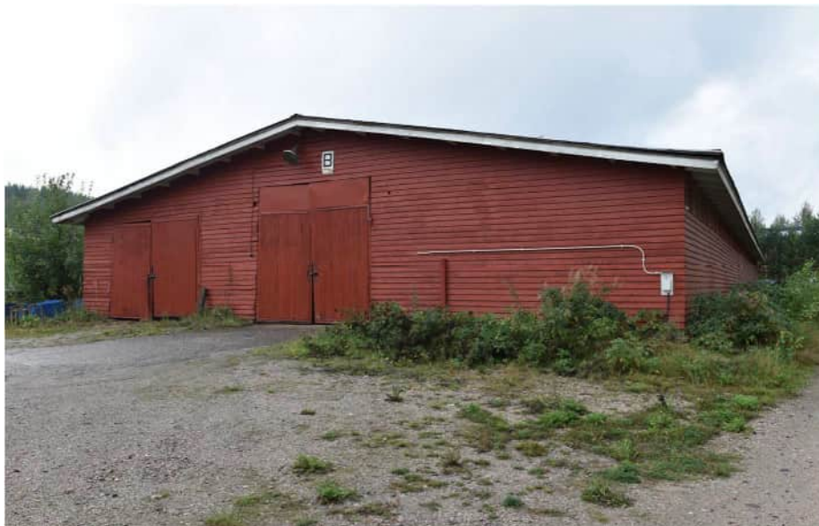
Kuva: Nro 8 Radiaattorivarasto (1022159933, RL 1962). Ulkoseinissä on viistopintainen vaakalaudoitus jiirinurkin.
