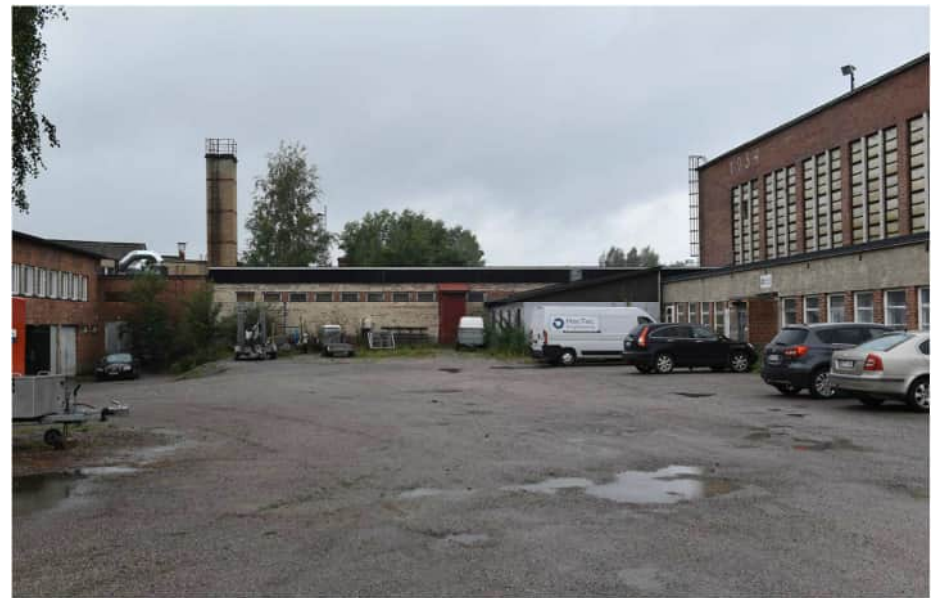
Kuva: Radiaattoritehtaan ja kattilahitsaamon välinen matala yhdyskäytävä.
