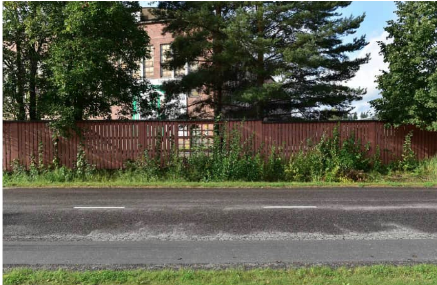
Kuva: Tehdasalue on aidattu katuihin rajautuvilta osin puuaidalla, joka on suurelta osin maalattu punaiseksi. Aita on korkea, mutta siihen on saatu keveyttä pystylaudoitukseen jätetyin raoin sekä rimoitetuilla jaksoilla, jotka avaavat näkymiä tehdasalueelle.
