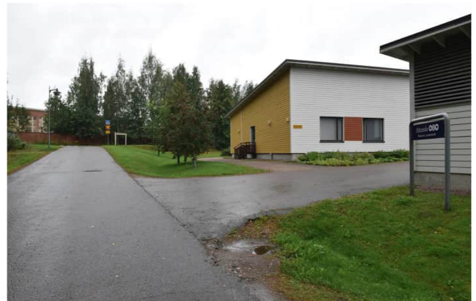
Kuva: Voudinlahden rannalla sijaitsi yhtiön pumppaamo. Nykyään Lauttarannaksi nimetyn kadun päässä on levennetty maapenger ja neljä kaksikerroksista paritaloa (2004–06). Kadun alkupäässä on 2013 valmistunut Attendon Tähtinimen hoivakoti.
