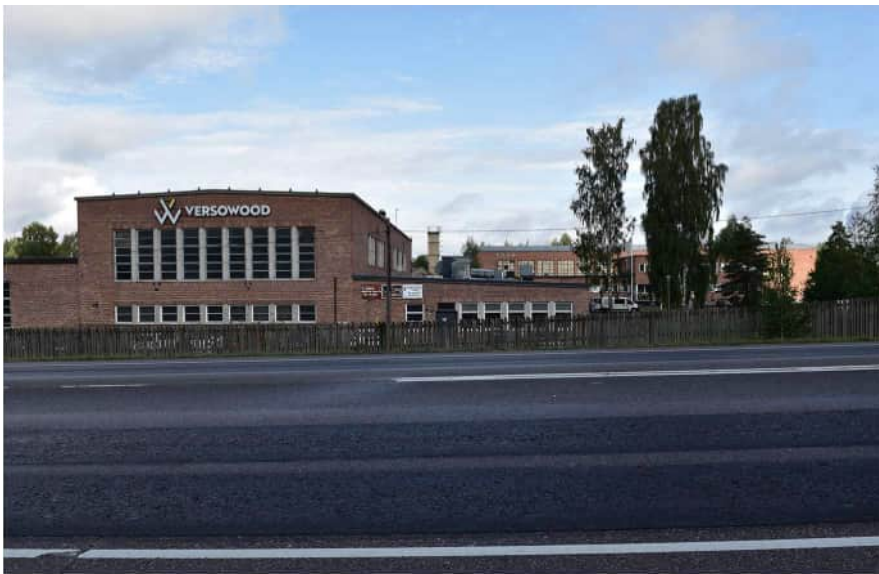
Kuva: Tienpinta on noussut siitä, mikä se oli tehtaan rakentamisen aikaan 1950-luvulla. Radiaattoritehtaan Lahdentien puoleinen julkisivu on vuosien 1956 ja 1964 laajennusta.
