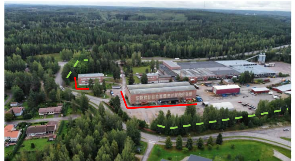
Kuva: Erillinen konttorirakennus ja kattilahitsaamo hallitsevat Tähtiniementien alkupään kaupunkikuvaa. Konttorin kulmalla on pieni tammimetsikkö.
