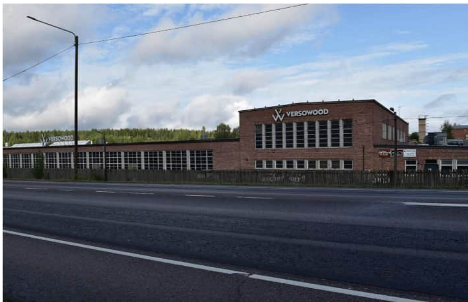
Kuva: Tehdasrakennuksen korkea pääty ja pitkä julkisivu Lahdentien suuntaan. Korkeimman osan huonekorkeus on lähes 10 m. Julkisivumuuraus on tehty ristilimityksenä. Pulpettikattoisen siiven pyöröikkuna on korvattu suorakaideikkunalla.
