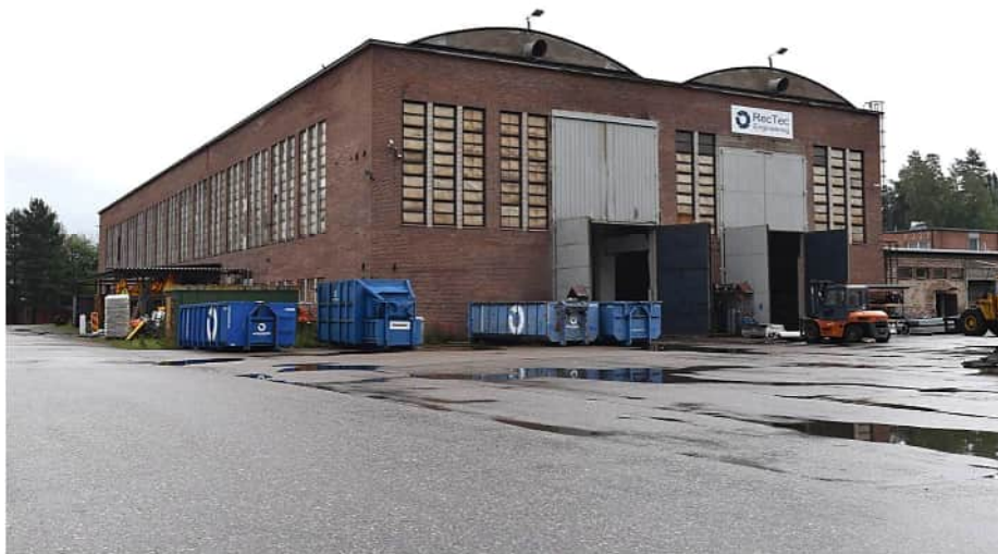
Kuva: Entisen kattilahitsaamon pääty on noin 33 metriä leveä. Suuret oviaukot on tehty jälkeen päin. Alkuperäinen hallinovi oli kuvassa näkyvistä vasemmanpuoleisen oven kohdalla, mutta sen yläreuna ylsi niukasti toisen ikkunaruudun tasolle.
