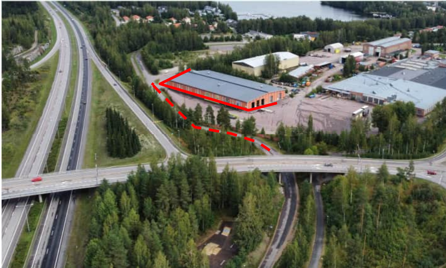
Kuva: Versowoodin teollisuusvarasto hallitsee Kauppakaaren katutilaa maantiesillan pohjoispuolella.
