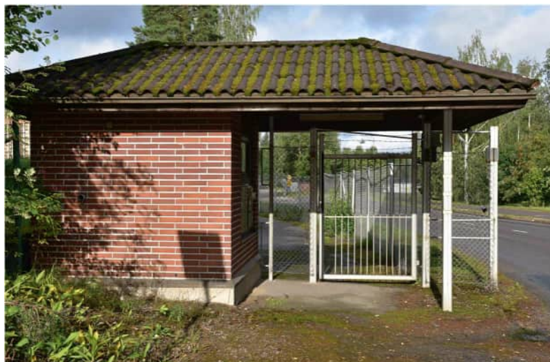
Kuva: Nykyinen tehtaan portti tehtiin Tähtiniementien varteen 1983, samalla rakennettiin henkilöportin viereen porttikoppi (nro 6). Seinärakenne: tiili, rako, tuulensuojalevy, villa, runkotolpat, höyrysulku ja lujalevy. Katteena Vartti-levyt.
