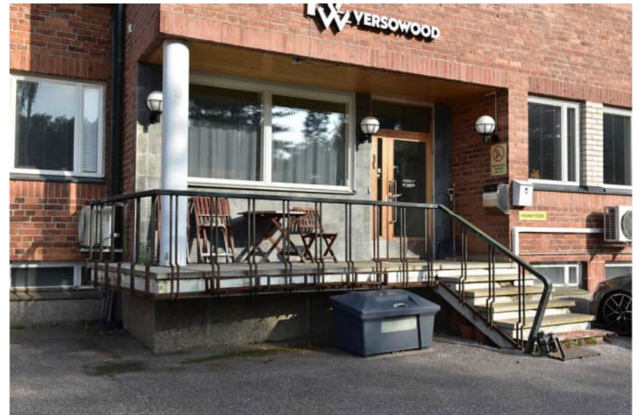
Kuva: Vuonna 1957 rakennetun kaksikerroksisen konttorisiiven pääsisäänkäynnin yhteydessä on säilynyt alkuperäisiä elementtejä, kuten pylväs, metallikaide ja kivilaatat.
