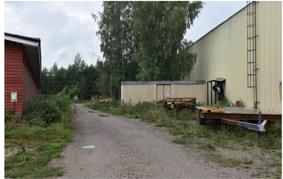
Kuva: Nro 10 muuntamo ja nro 9 tehdasrakennus (1022159911) eli entinen kokoonpanohalli.
