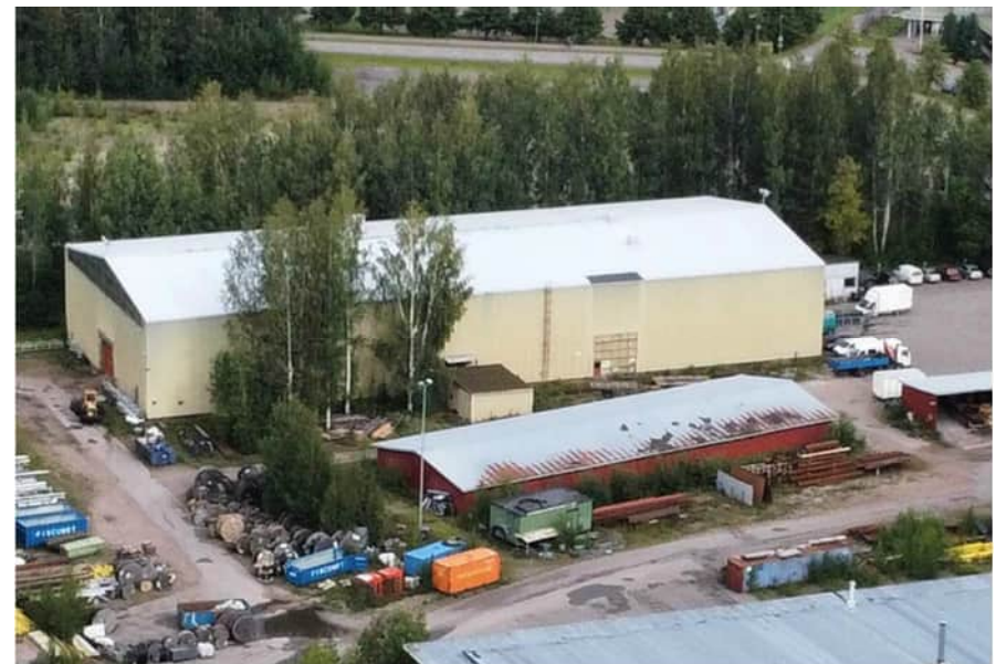
Kuva: Nro 9 tehdasrakennuksessa (1022159911, RL 1975) on peltikatto, profiloitu muovipintainen? teräslevy (alkuperäinen punainen väri kauhtunut pois), betonisokkeli ja teräskarmi-ikkunat. Vesikattoa kannattelevat teräsristikot.
