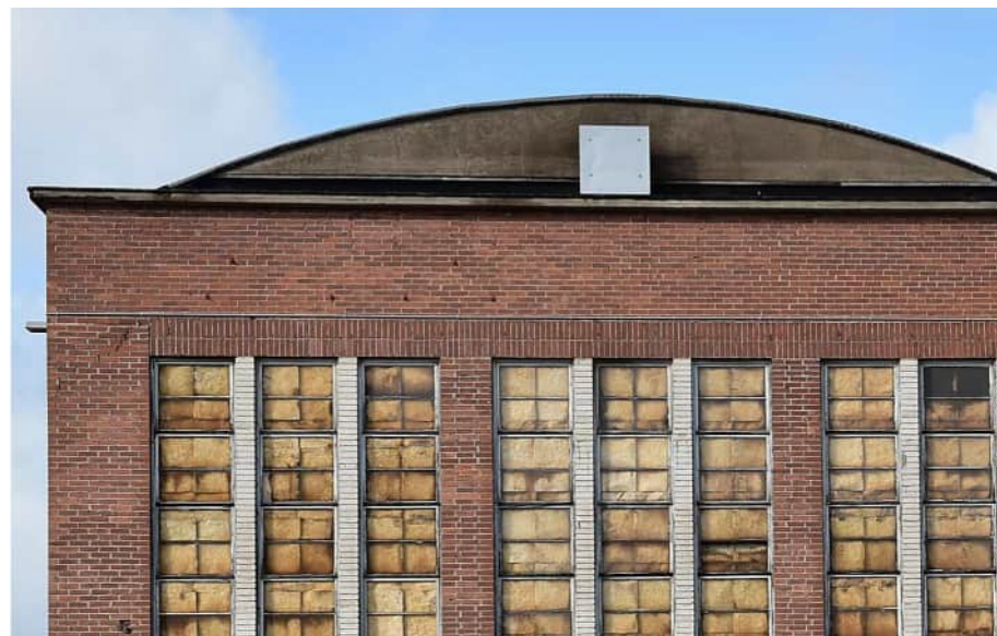
Kuva: Rakennuksen punatiiliseinä juoksulimityksellä, seinissä ½ kiven ja ikkunoiden väleissä ¼ k siirtymällä. Ikkunapilarit ovat kahi-tiiltä. Ikkunapuitteet ovat vanhat.
