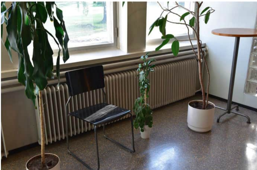
Kuva: Erolan lounasravintolan eteistilaa. Tehtaan ikkunat ovat pääasiassa vanhoja. Ikkunan alla on pinta-asennettu Högforsin Kesto-radiaattori.
