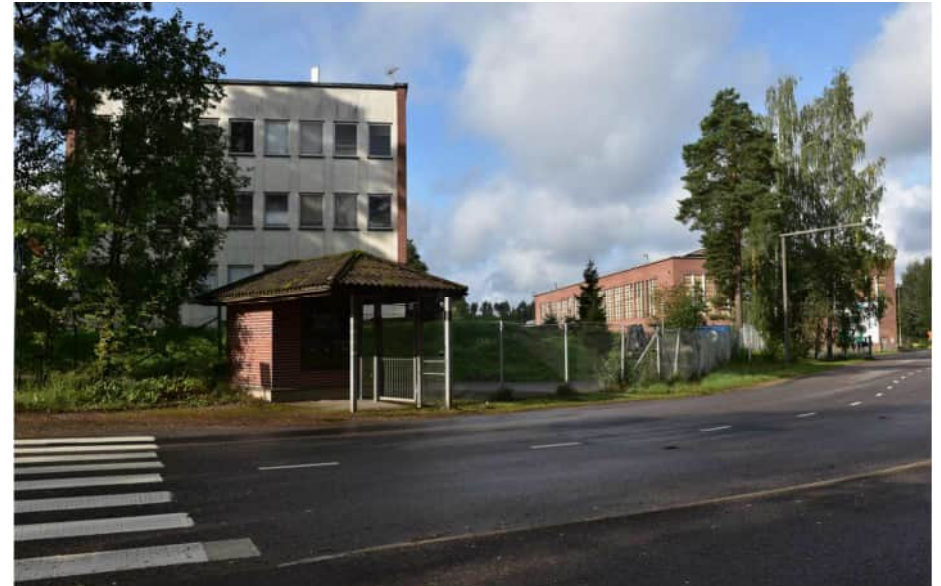
Kuva: Tähtiniementien porttirakennus ja metalliverkkoaitaa. Ajoportti on edempänä vanhan kattilatehtaan kohdalla.
