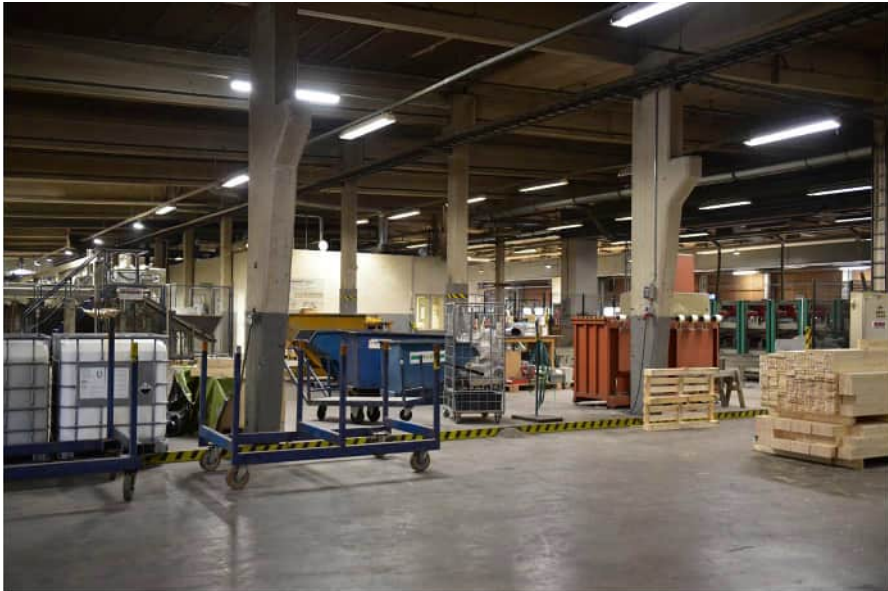
Kuva: Tehtaan eri-ikäiset osat muodostavat suuren hallitilan, jota rytmittävät betonipalkkeja kannattelevat betonipilarit. Hallitiloihin ei avaudu kattoikkunoita. Viimeisen käyttötarkoituksen yhteydessä on purettu muutamia pilareita.
