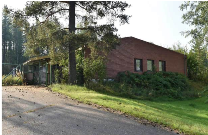
Kuva: Nro 5 Portinvartijan rakennus (1022159999) toimi viimeksi tehtaan terveysasemana, nykyään tyhjiällä (varasto). Laajennusosan (1975) ja vanhan puolen yhtymäkohta erottuu tiilimuurauksessa. Portti jäi käytöstä 1980-luvulla.
