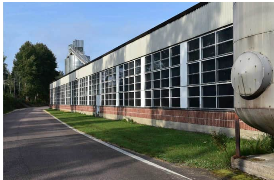
Kuva: Tehtaan viimeisen laajennuksen julkisivuissa on enemmän Minerit-levyä kuin punatiiltä. Ikkunat tehtiin vanhan mallin mukaan. Räystäspeltti on kuparia.
