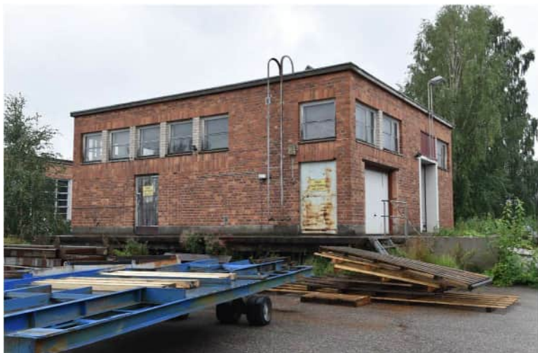
Kuva: Nro 4 Kaasunkehityslaitoksessa (ei tunnusta, Tor-Eric Herler 1952) oli oma huone hapen jakelulle, happipulloille ja karbidille sekä iso huone asetyleenin kehitykselle. Tiilirakennuksessa on loiva pulpettikatto ja tasapäädyt. Ikkunapilarit ovat kahi-tiiltä, kuten muissakin tiilirakennuksissa. Myöhemmin tehty muutoksia luoteisjulkisivun oviaukkoihin.
