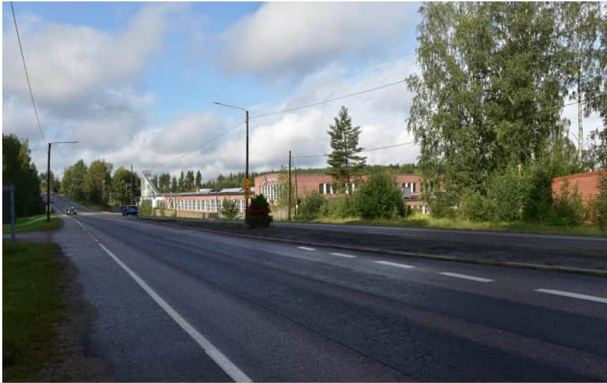
Kuva: Suoraa Lahdentietä tehtaan eteläpuolella. Näkymän päässä tie nousee mäelle, jossa sen kanssa risteää Hevossaarentie (eritasoliittymän silta). Jo ennen moottoritien rakentamista Lahdentielle oli rakennettu silta Hevossaareen vievän radan yli.
