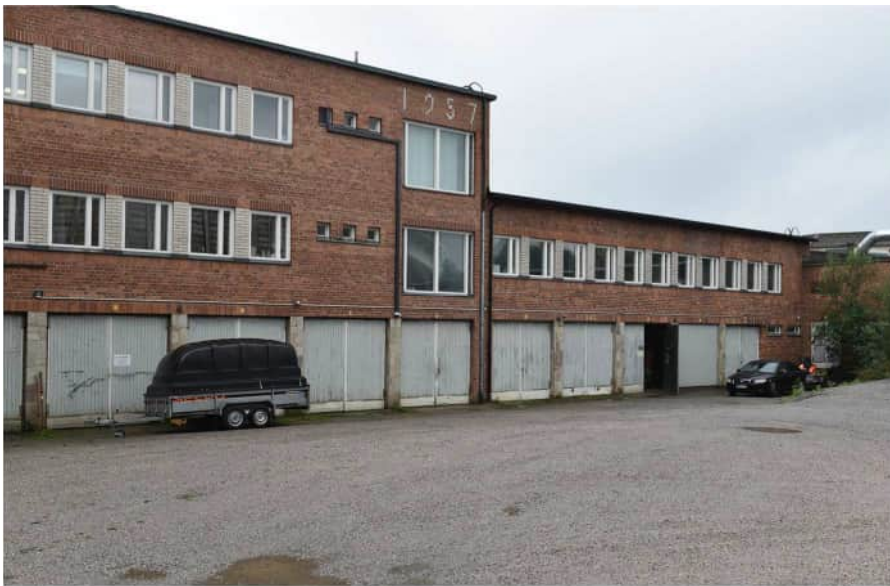
Kuva: Konttorisiipi rakennettiin samaan aikaan radiaattoritehtaan kanssa. Kaksikerroksinen laajennusosa on tehty 1957.
