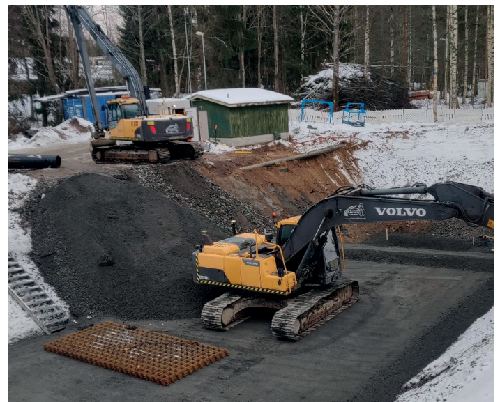
Sinilähteen jätevesipumppaamon rakennustyömaa.
