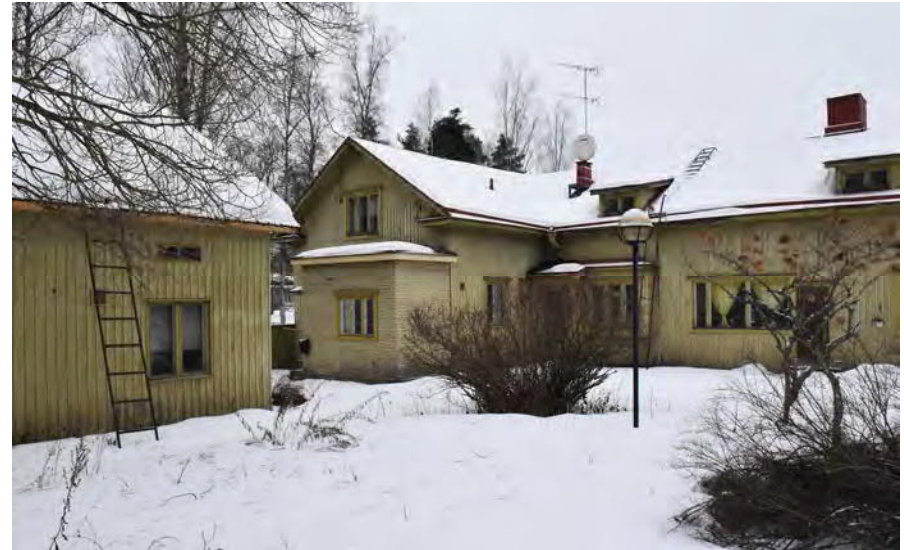
Kuva: Kirkkorinne 2:n pieni talo ja kulmatalo sisäpihalta kuvattuna.
