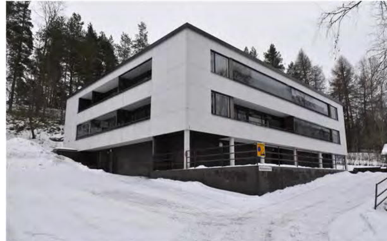
Kuva: As oy Torninsivun kerrostalot suunnitteli arkkitehti Eino Tuompo. Parvekkeita on jälkepäin lasitettu.
