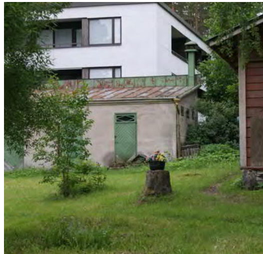
Kuva: Kirkkorinne 2:n vaja- ja ulkohuonerakennus.
