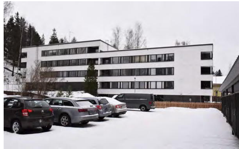
Kuva: Asuinkerrostalon pitkä massa on porrastettu. Modernissa rakennuksessa harkitut yksityiskohdat liittyvät massoittelemisen pieniin yksityiskohtiin, kuten rakennuksen päätyseinien kulmaparvekkeiden sekä kellarikerroksen sisäänvetoihin. Kadunpuoleista päätyjulkisivua on kevennetty pystylinjaisuudella, jota syntyy sisäänvetoihin yhdistetyillä pilareilla.
