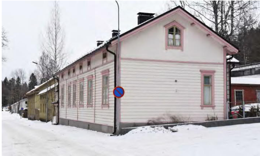
Kuva: Harjukatu 6 etualalla ja sen perässä Kirkkorinne 2:n puutalot. Takana ulkorakennus vuodelta 1906.
