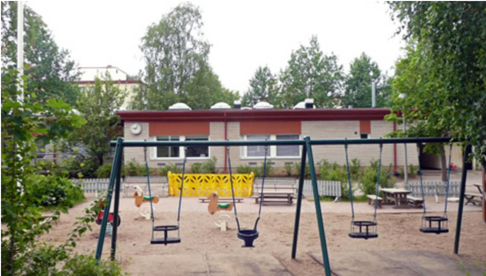
Päiväkoti purettiin kosteusvaurioiden vuoksi.
