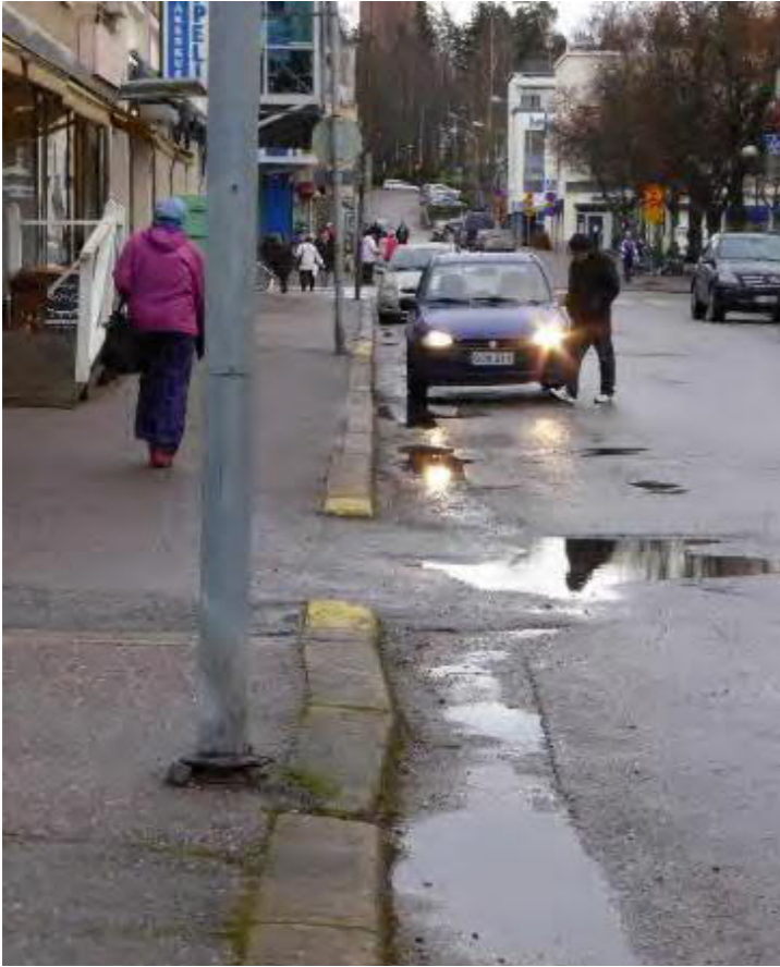
Kuva 1/16, Kirkkokadun peruskorjattava osuus
