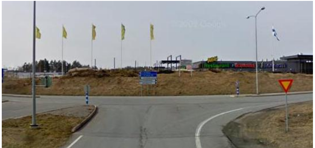
Kuva 14. Vt 4 ramppiliittymä Sukurantielle. (Kuvan lähde: maps.google.fi)
