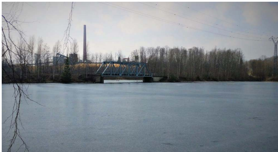
Maitiaislahden yli kulkeva teollisuusraide ja silta.
